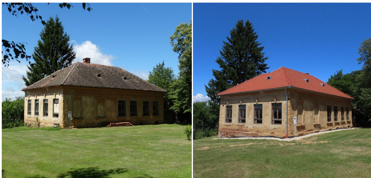
Slika 1: Stara šola v Kančevcih, streha pred in po obnovi (foto: Primož Presetnik, 10. 7. 2017 in 9. 7. 2021).
