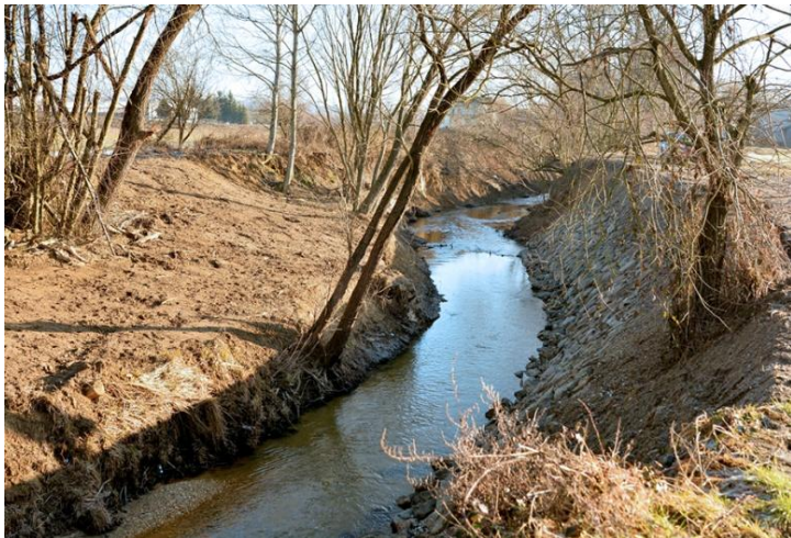
Slika 27: Utrjeni del Velike Krke v k.o. Krplivnik. Utrditve so bile izvedene v novembru 2014
