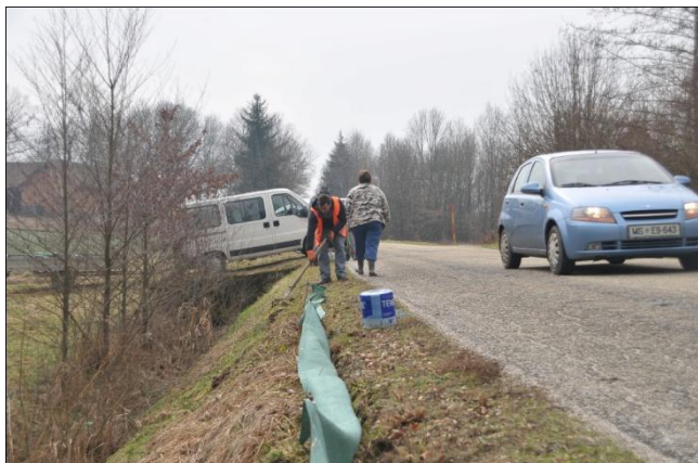
Slika 15: Postavljanje zaščitnih mrež ob lokalni cesti Krašči-Ropoča
