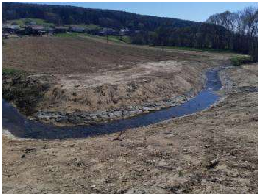
Slika 6. Utrditev bregov Bodonskega potoka izveden brez dovoljenj (foto: K. Malačič)
